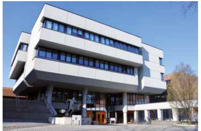
Gebäude des ZSportMedBw nach vollständiger Sanierung 2012 (Abb: Bundeswehr/Andreas Lison)
